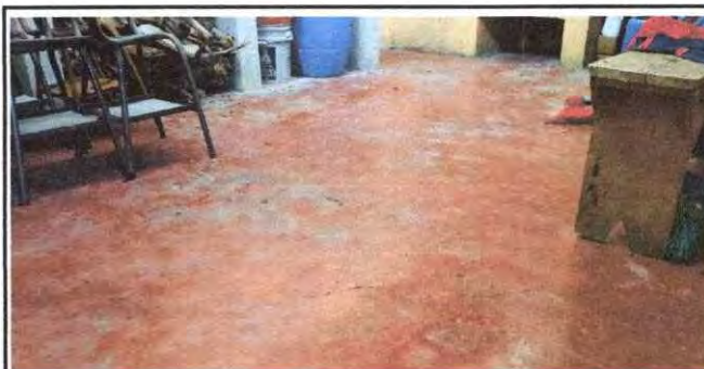
Foto 16: Colocación de piso liso a piso cerámico.
