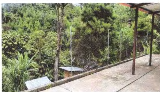
Foto 17: Sustitución de Tubo Galvanizada por columnas y Malla Galvanizada. 18 mts. Lineal.
