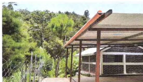
Foto 14: Sustitución de Tubo Pvc 3" Canal de Metal. 10mts. Largo.
