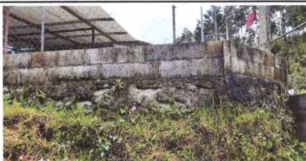
Foto 11: Reforzamiento de columna de muro de contención.
