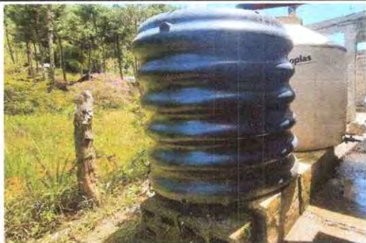
Foto 13: Sustitución de depósito de agua Tinaco, accesorios y base de concreto.
