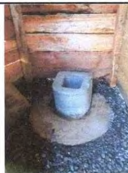
Foto 18: Colocación de torta de cemento, sustitución de letrina de cemento a plástico.
