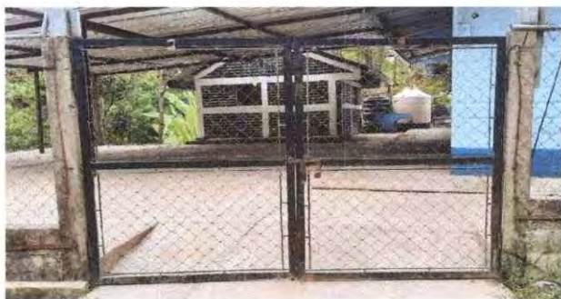
Foto 7: Sustrucción de Porton de Ingreso.
