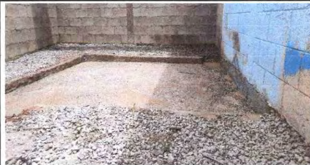
Foto 4: Sustitución de piso de torta de concreto por piso cerámico 7.50x4mts. Modulo Preprimaria.
